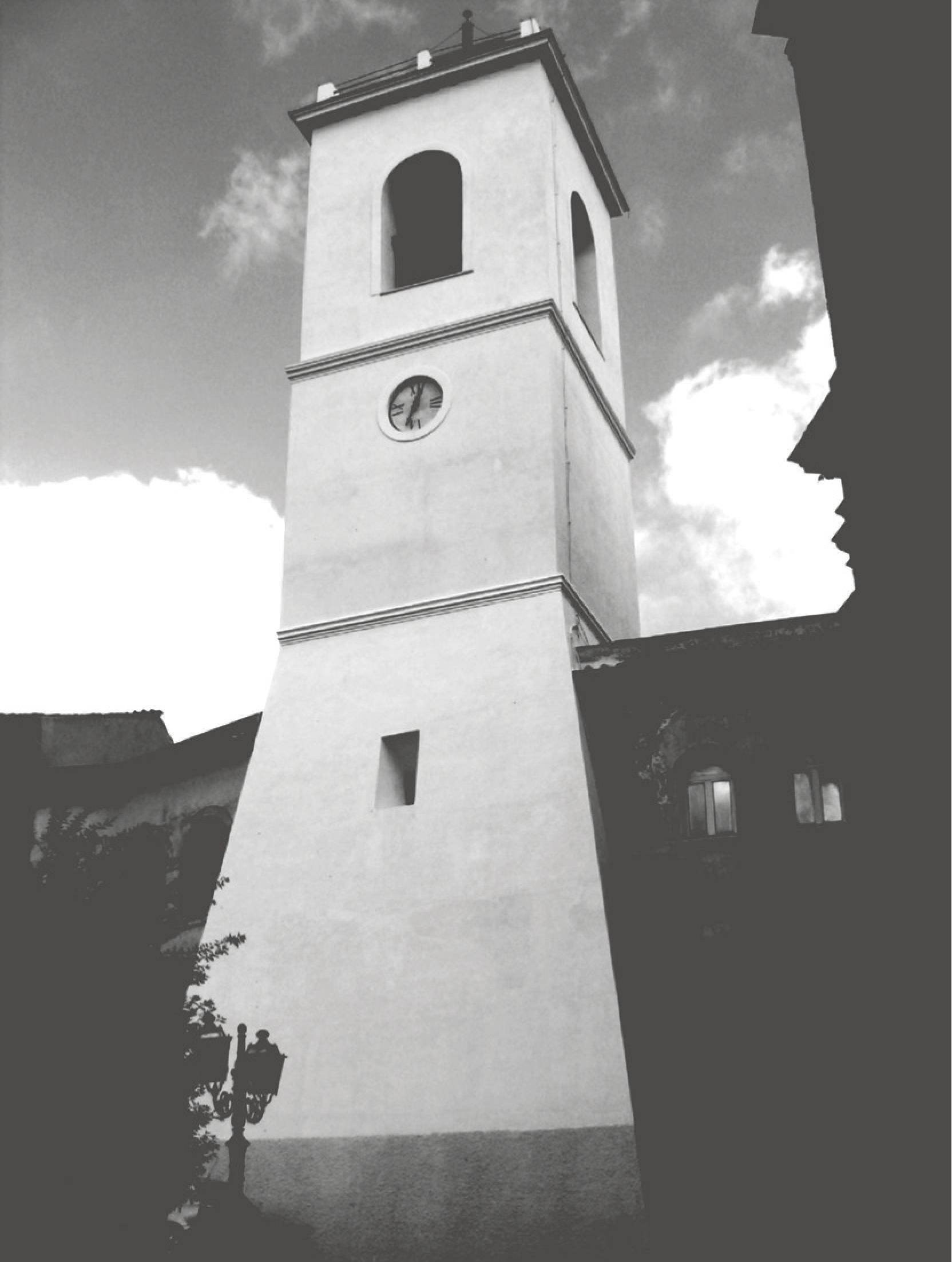
Cantiere "Torre Campanaria del Comune di Montecompatri"
