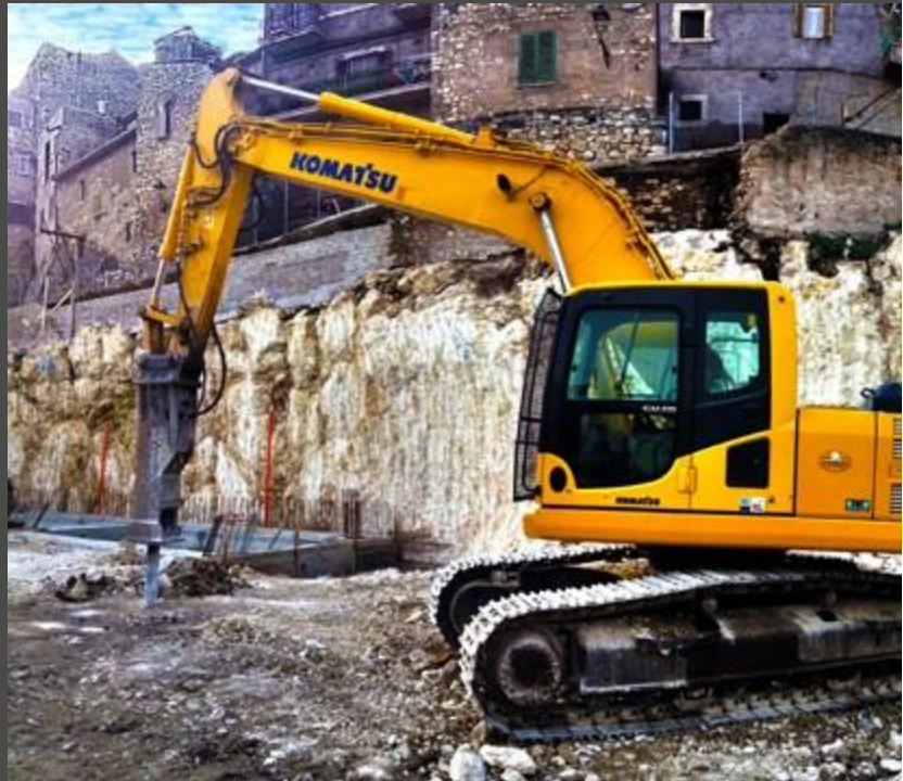
Cantiere "Guidonia Montecelio"
